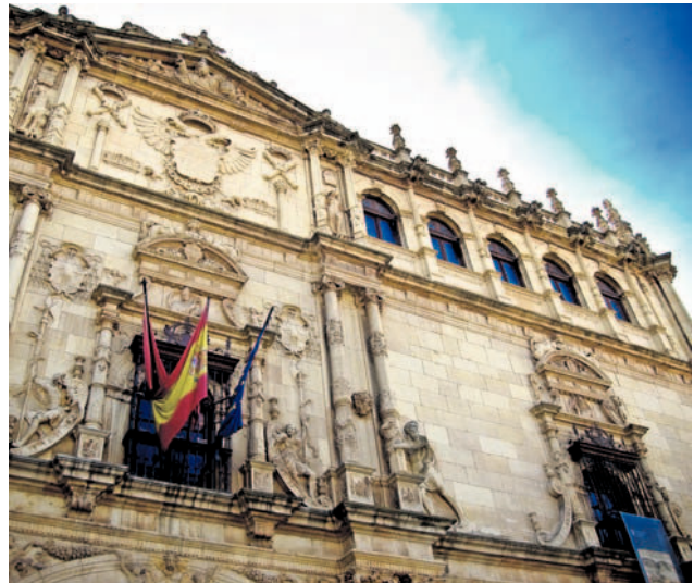
Fachada de la Universidad de Alcalá de Henares (Madrid). GETTY IMAGES
