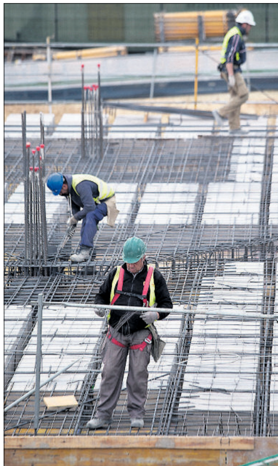
Varios trabajadores en una obra en Bormujos (Sevilla). / PACO PUENTES
